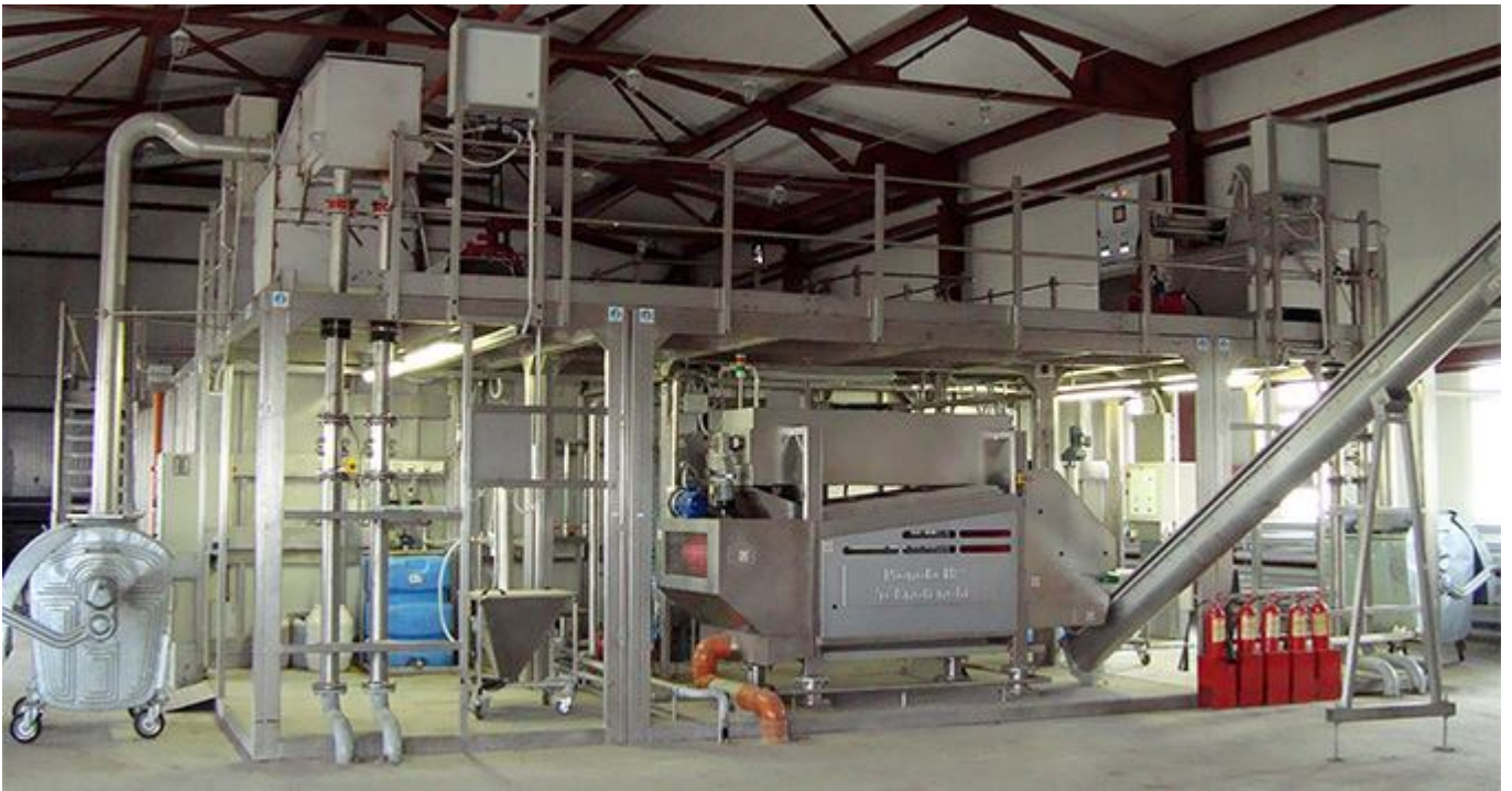
Рисунок 4.1 – Канализационные очистные сооружения в блочно-модульном исполнении
